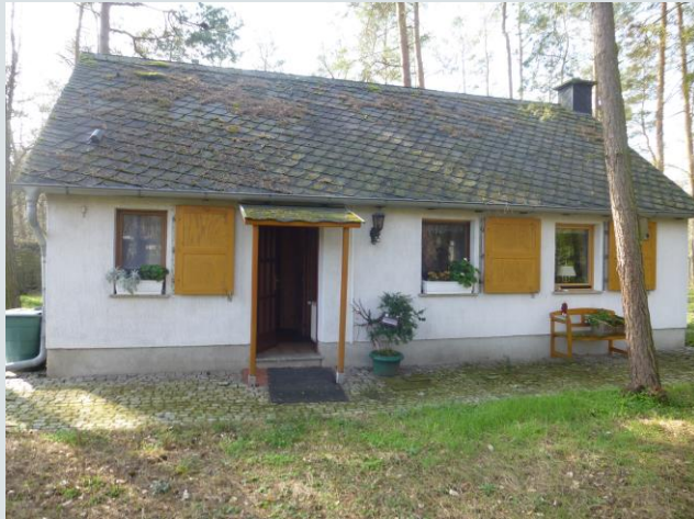
Vorderansicht, mit Blick auf den Eingangsbereich
